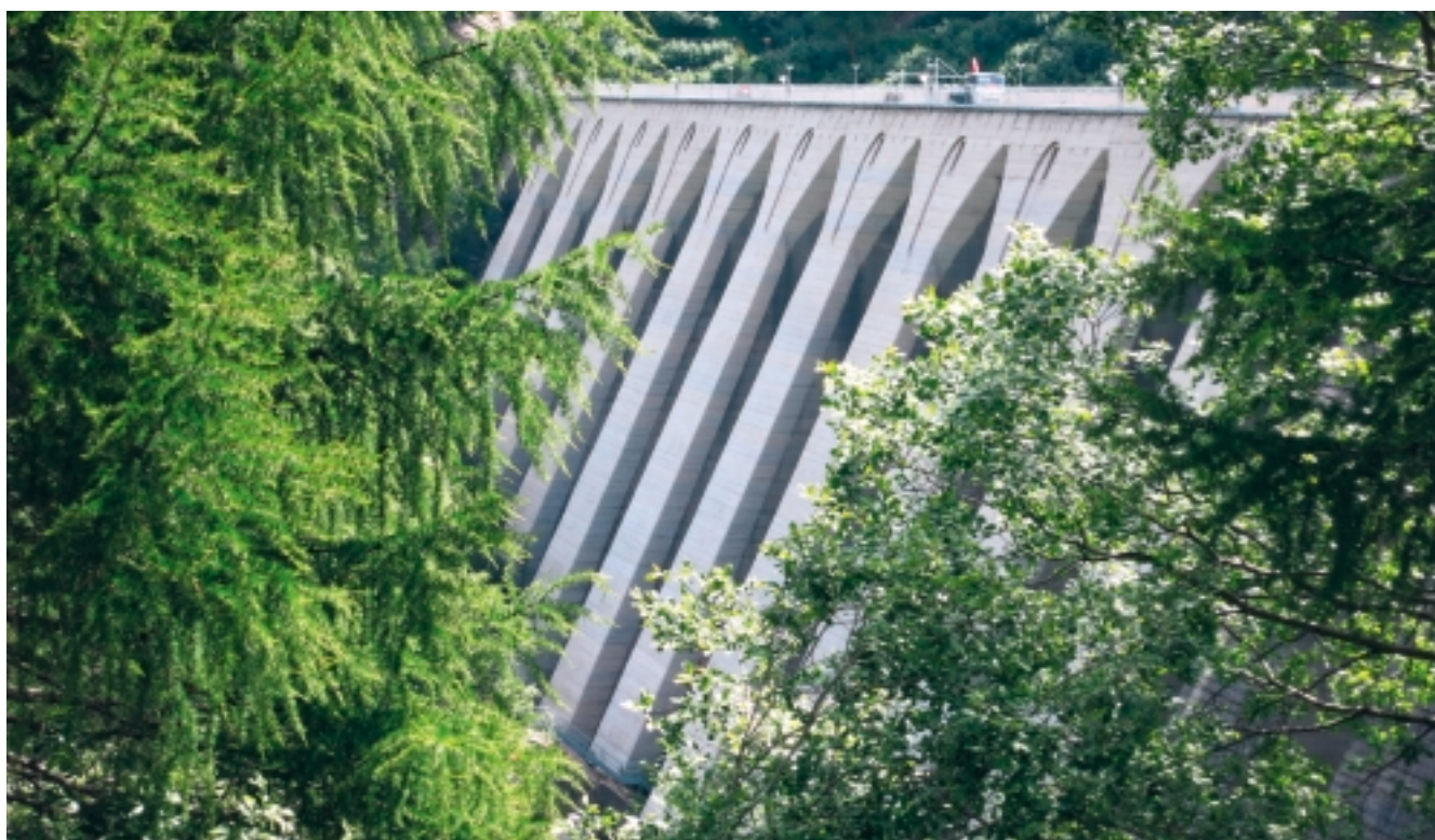
Diga di Gioveretto vista da valle.
